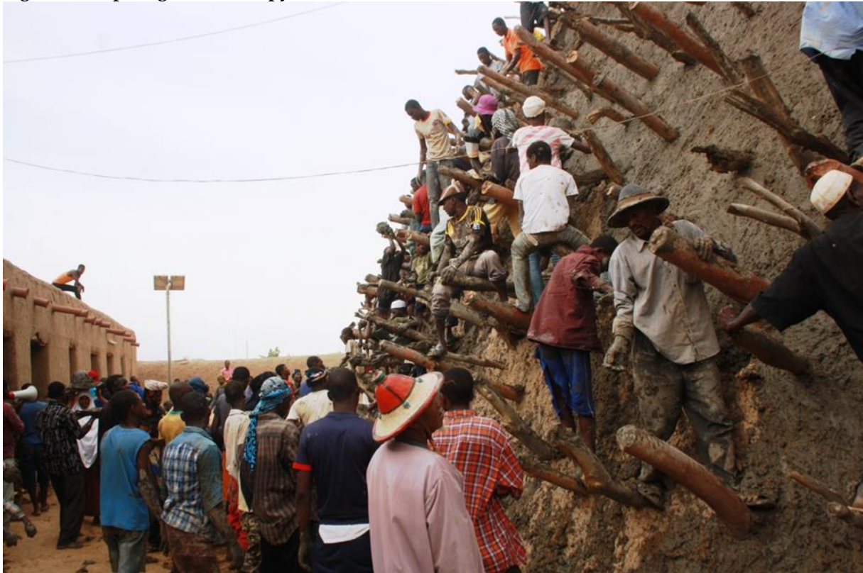
Figure 1: Crépissage de la tour pyramidale du Tombeau des Askia
